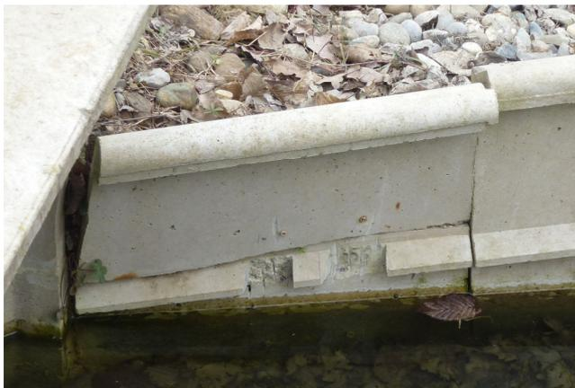
Fig. 6 : Élément de barrière en train de s'effondrer.
